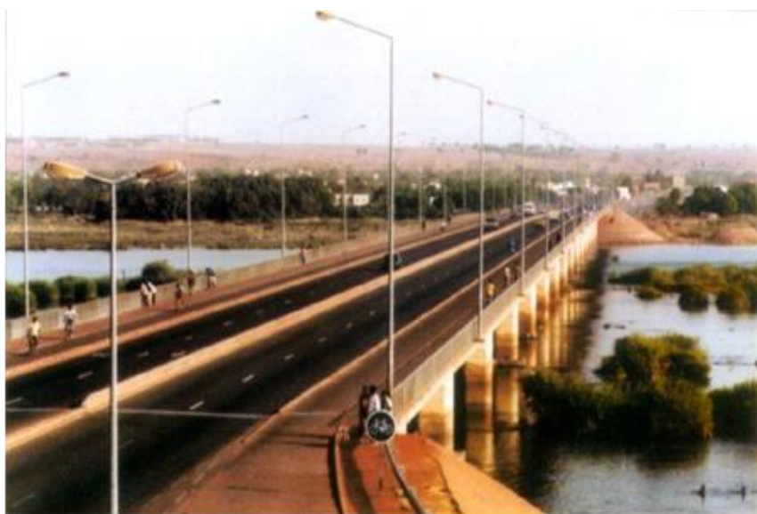
中国海外工程总公司建设的巴马科二桥
