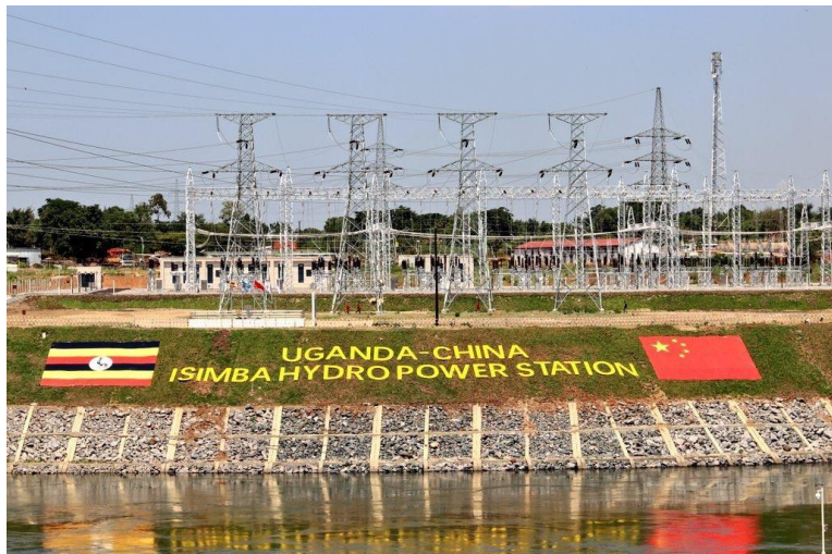
伊辛巴水电站
